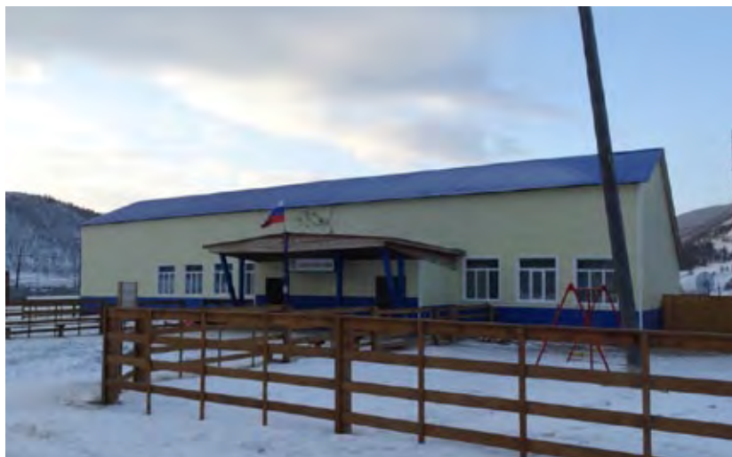
Отремонтированный Дом культуры, Бугульдейское муниципальное образование Иркутской области
