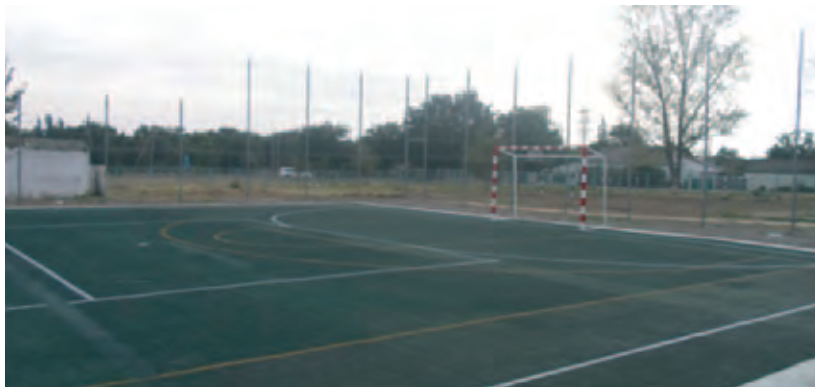
Обустройство спортивной площадки на территории муниципального казенного учреждения "Физкультурно-спортивный патриотический комплекс «Русич» в с. Правокумское, Ставропольский край
